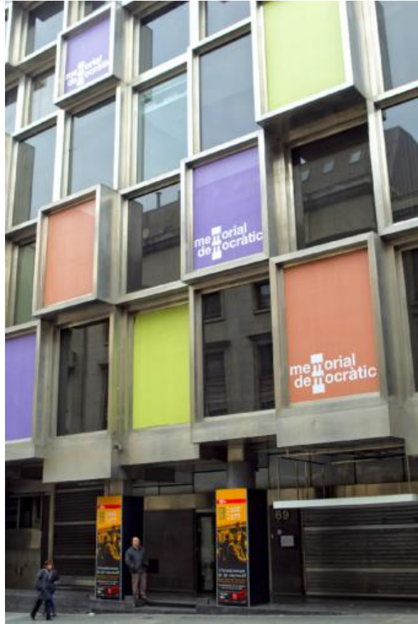
El edifici que acogia el Memorial Democràtic.- MARCEL·LÍ SÀENZ
